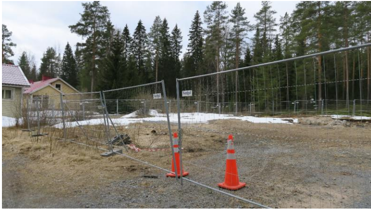
Kuva 88. Purettu rakennus A 30 tontti olivat maisemoimatta touku-kuun alussa 2022.
