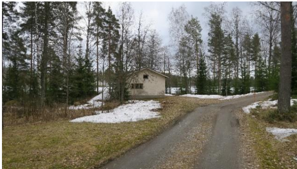
Kuva 67. Tie Rautonimeen kärkeen ja entinen pumppuhuone.
