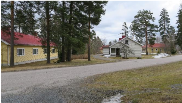
Kuva 71. Otavantien yli näkymä rakennus A 21 ja 19 pihapiiriin.
