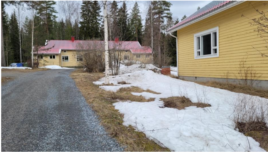
Kuva 77. Rakennus A 24 sivuitse näkymä kohti tien päätettä rakennus A 26.
