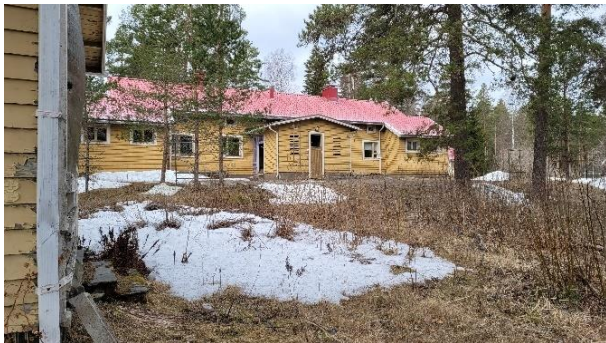
Kuva 84. Näkymä rakennus A 18 nurkalta kohti rakennusta A 22.
