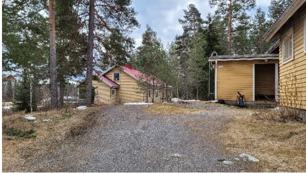
Kuva 82. Näkymä rakennus A 22 pihalta kohti rakennusta A 18.
