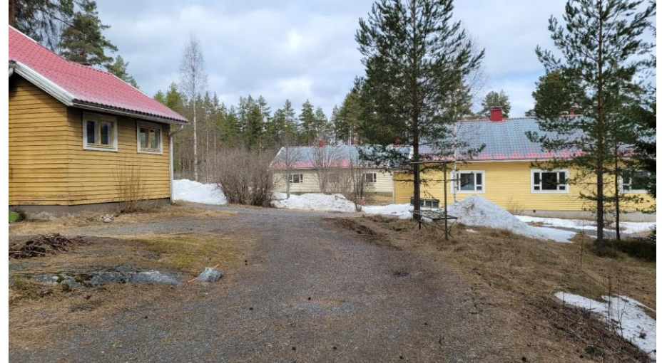
Kuva 85. Rakennuksen A 22 pihalta näkymä kohti rakennuksia A 24 ja 28.
