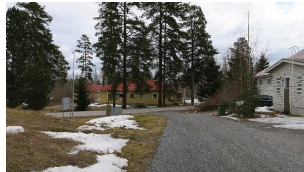
Kuva 76. Rakennus A 20 a sivuitse näkymä Otavantien itäpuolelle.
