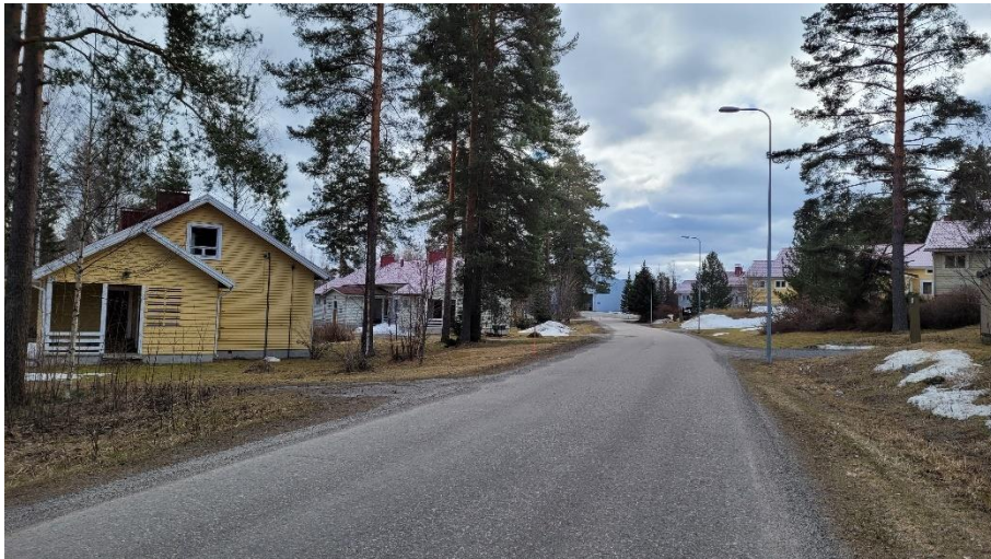
Kuva 51. Otavantien itäpuoli ja rakennukset A 21 ja 19.
