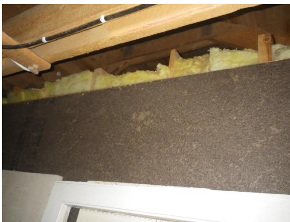
Yläpohjan mineraalivilla lisälämmöneristys.
