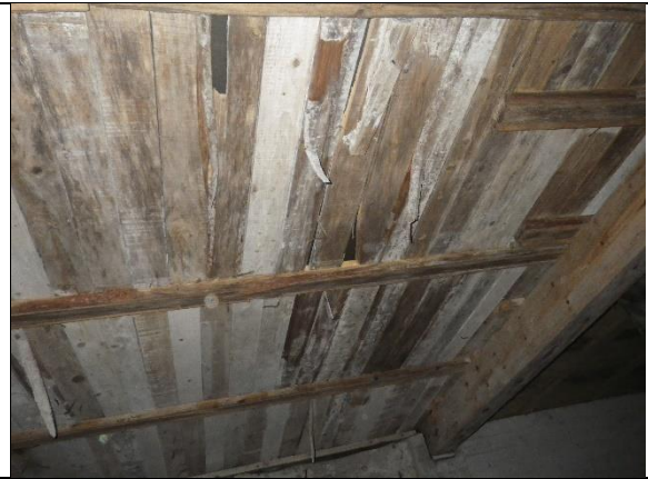
Ryömintätilan alkuperäistä alapohjarakennetta.
