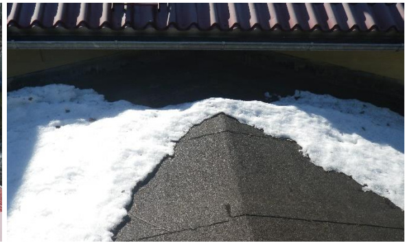
Huopakatto sisääntulon päällä.
