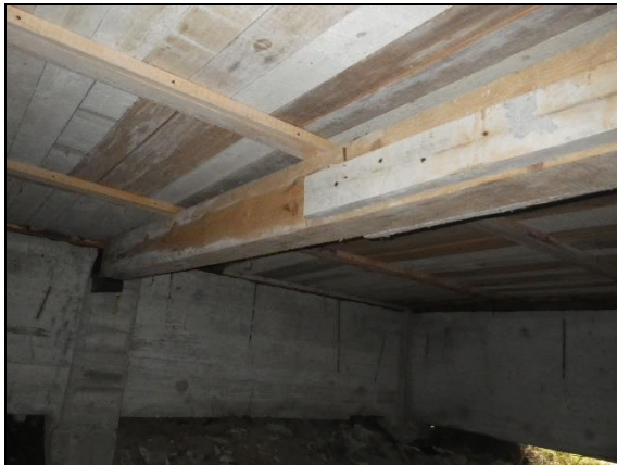
Alkuperäinen vaurioitumaton alapohjarakenne.
