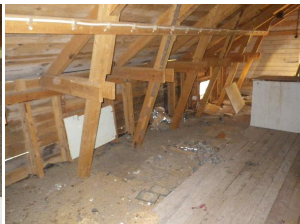
Yläpohjarakenne on hyvässä kunnossa.
