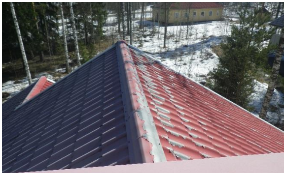
Maalattu tiilikuvioitu peltikatto.
