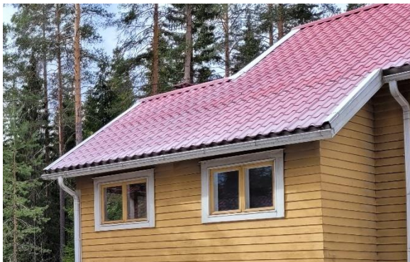
Tiilikuvioitu peltikaton haalistumista.
