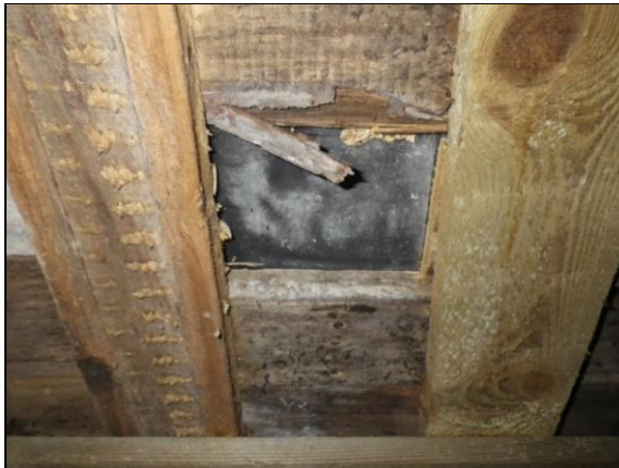
Alapohjarakenteen tervapaperia.
