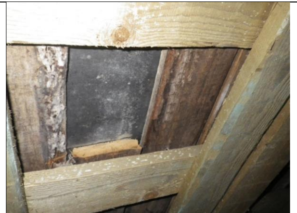
Alapohjarakenteen tervapaperia.
