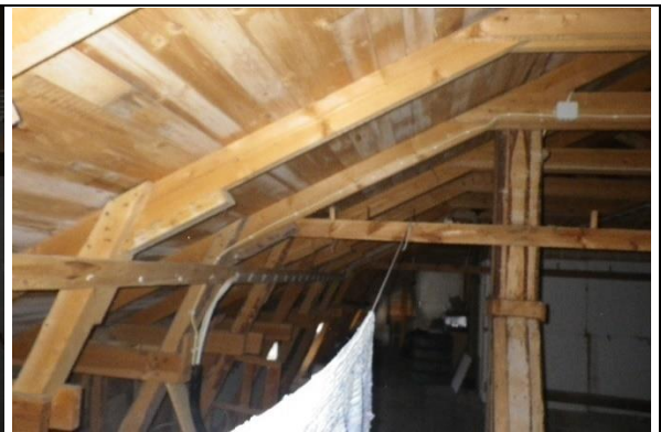
Yläpohjarakenne on hyvässä kunnossa.
