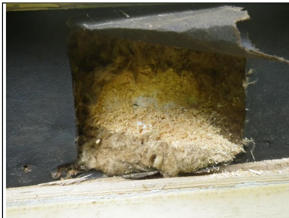
Ulkoseinärakennetta rungon alaosassa alapohjan kohdalla.
