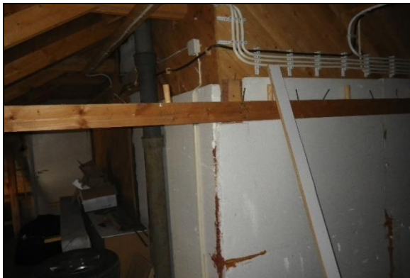
Yläpohjan tilojen solumuovilevyisälämmöneristys.
