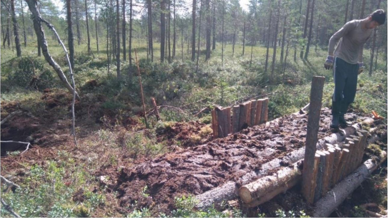
Kuva 13. Käsityönä tehtävän padon malli kuvattuna rakennettaessa.
