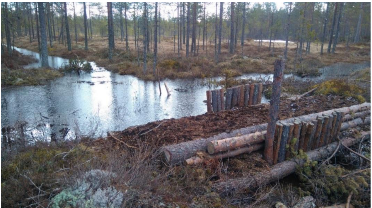
Kuva 14. Käsityönä tehtävän padon malli kuvattuna rakentamista seuraavana keväänä.
