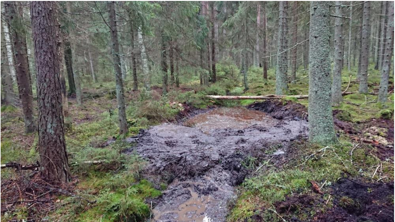
Kuva 10. Esimerkki pienestä kaivinkoneella tehdystä padosta heti työn jälkeen.
