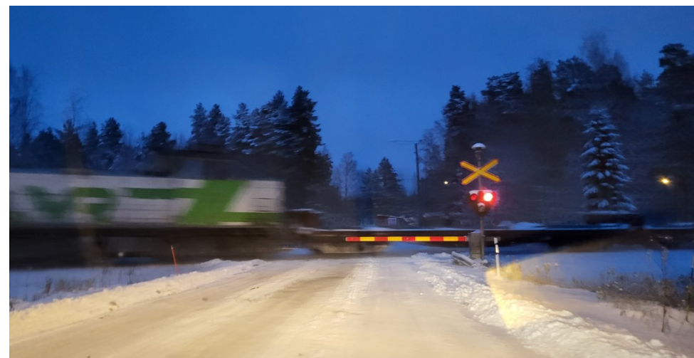
Kuva 101 Rautatie Inhantehtaan tien ylityskohdalla
