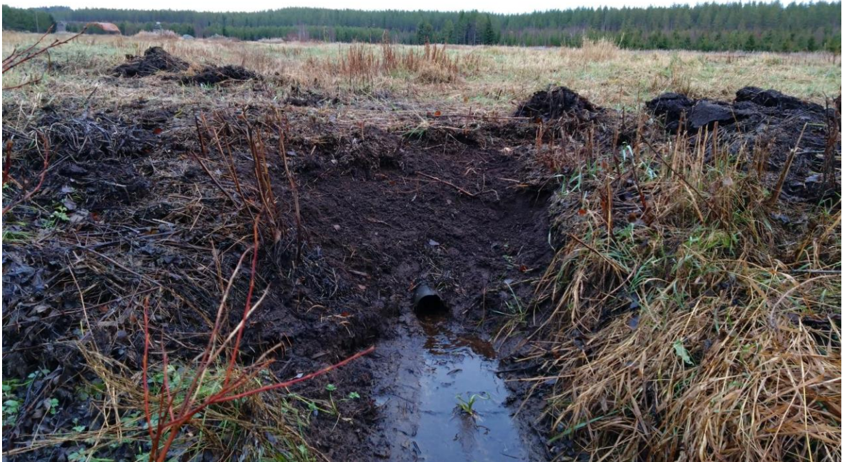
Kuva 4. Turvepellolla ylläpidettävä vedenpinnan korkeus ratkaisee turpeen lahoamisen. Rääsyn salaoja.
