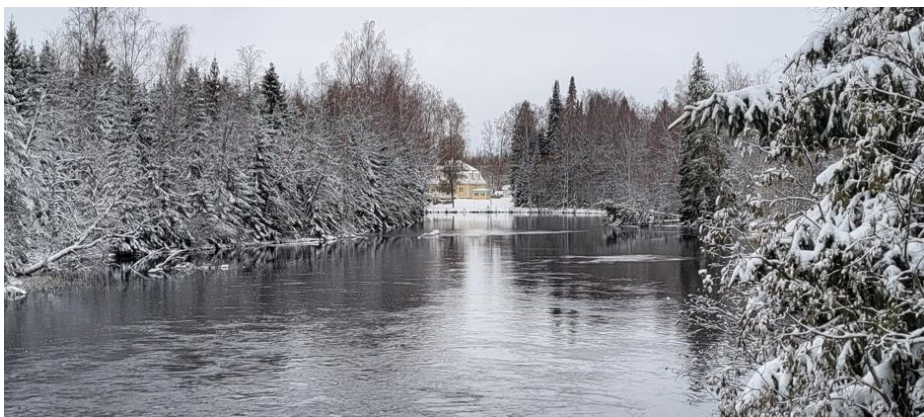
Kuva 49 Vääräkosken kartonkitehdas vesistönäkymässä.
