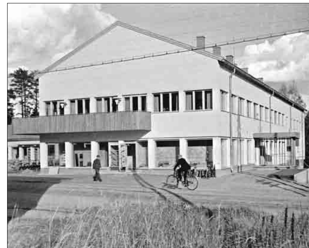
Osuusliike Keski-Suomen myymälä- ja hotellirakennus valmistui vuonna 1948. Tyyliltään funktionalistinen rakennus oli ensimmäisiä moderneja liikekiinteistöjä Keuruun keskustassa. Nykyisin rakennuksen paikalla on vanhoja kantavia rakenteita hyödyntäen tehty liike-asuinrakennus Tarhiansuu.
