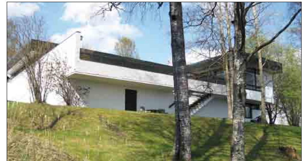
Arkkitehti Erkki Virkkusen suunnittelema Keuruun uusi pappila noudattaa 1960-luvun arkkitehtuurin ihanteita tasakattoineen, valkotiilijulkisivuineen, nauhaikkunoineen ja patiolle avautuvine maisemaikkunoineen.
